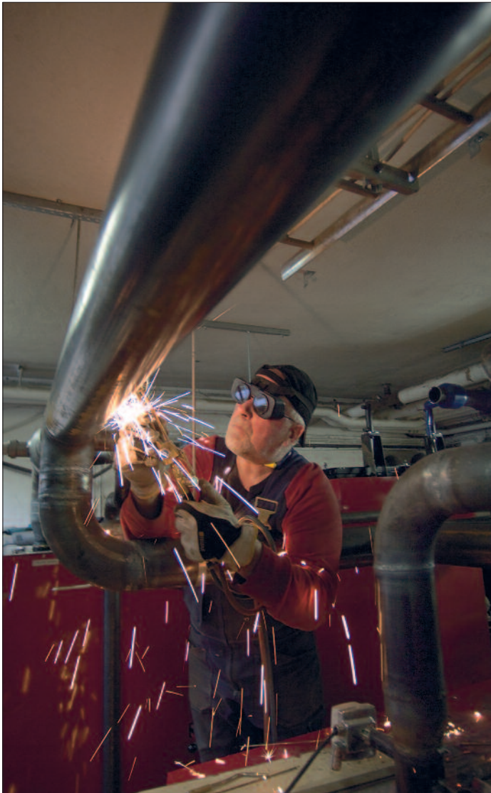
Lennart Karlsson från Lillholmsjö svetsar ihop de sista skarvarna. Lagom till jul ska fjärrvärmen vara igång i Kyrktåsjo. Foto: GUNNO RASK
